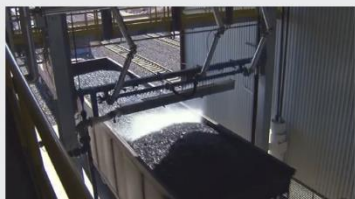
aplikacja roztworu RENOCLEAN AIR LOCK-DOWN za pomocą systemu zraszającego
